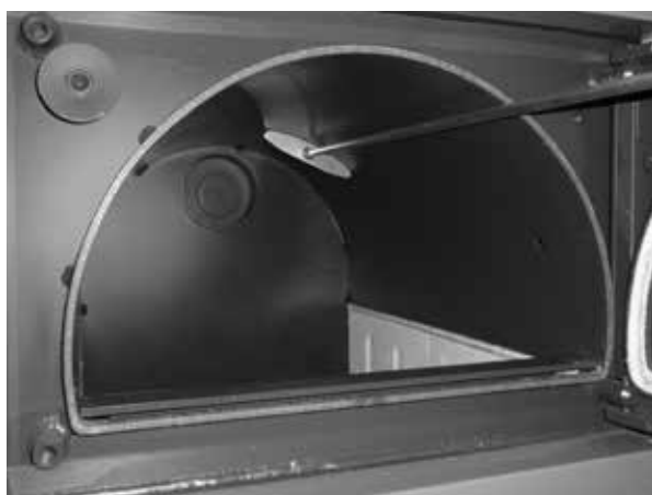
Czyszczenie górnej komory ładowania porzebaczem
